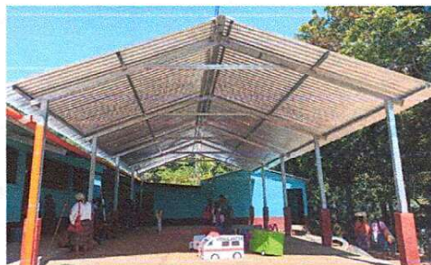
Foto 2: ESTRUCTURA METÁLICA Y LÁMINAS TROQUELADAS EN SALÓN DE USOS MÚLTIPLES
